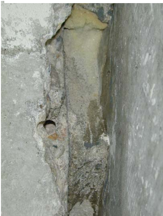
Mauerausbrüche beim Entfernung der PCB-haltigen Fugenmassen
