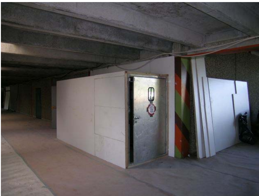
2-Kammer-Schleuse zum Sanierungsabschnitt 1 und 2 im Trakt B
