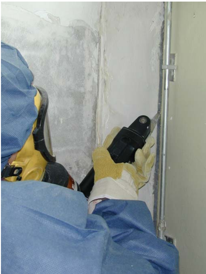
Entfernung der PCB-haltigen Fugenmassen mit einem Spezialwerkzeug (sog. oszillierendes Messer)
