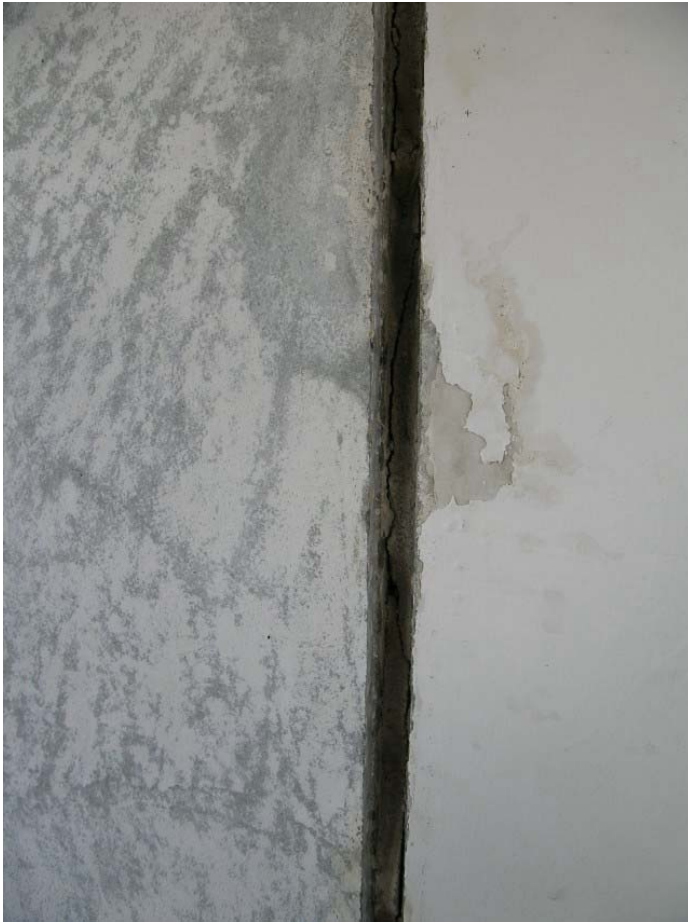
Fuge im Klassenraum nach Entfernung des Fugenmaterials
