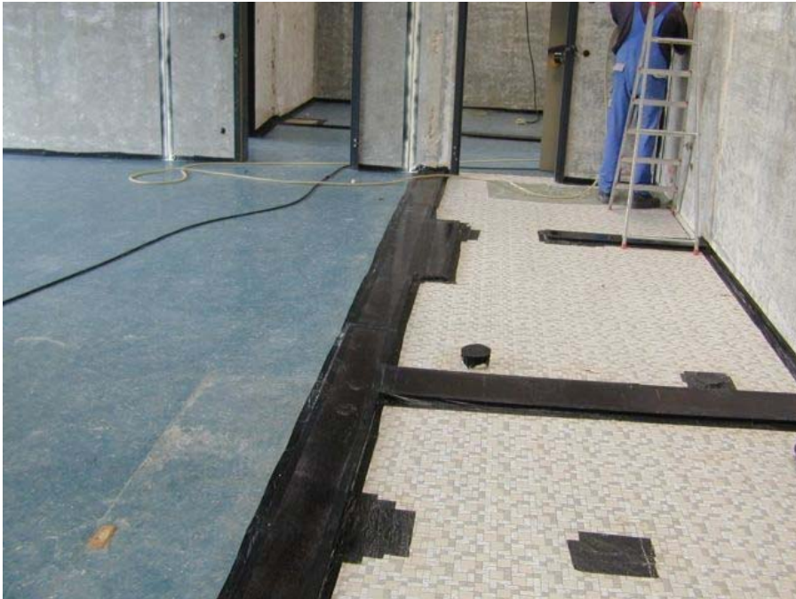
Der Estrich, bzw. offene Bodenbereiche wurden durch Abkleben geschützt.
