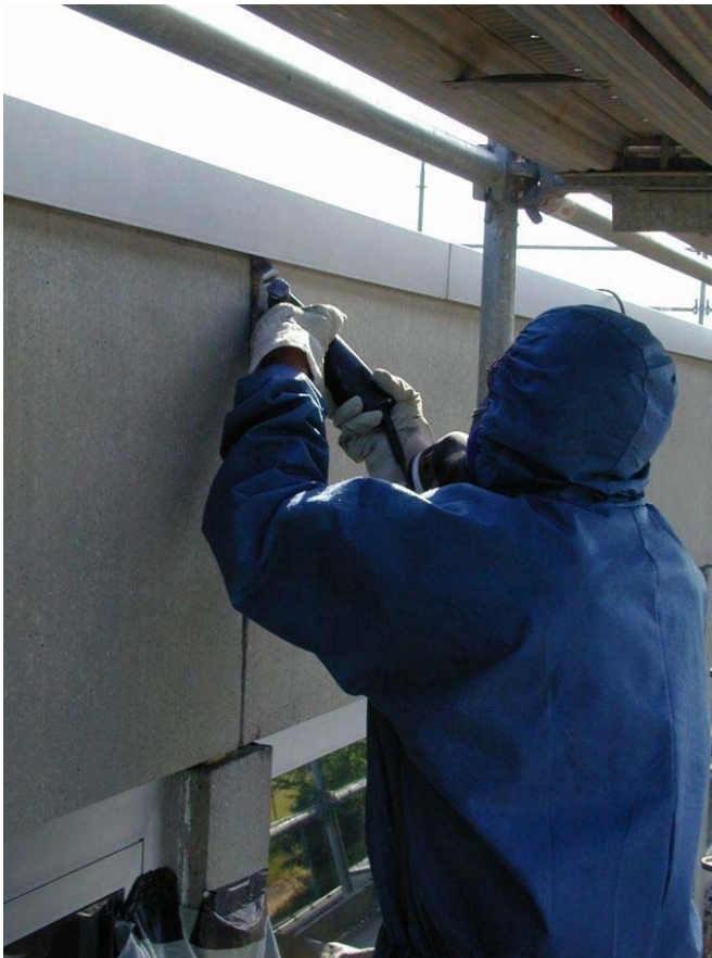
Fugentfernung im Außenbereich
