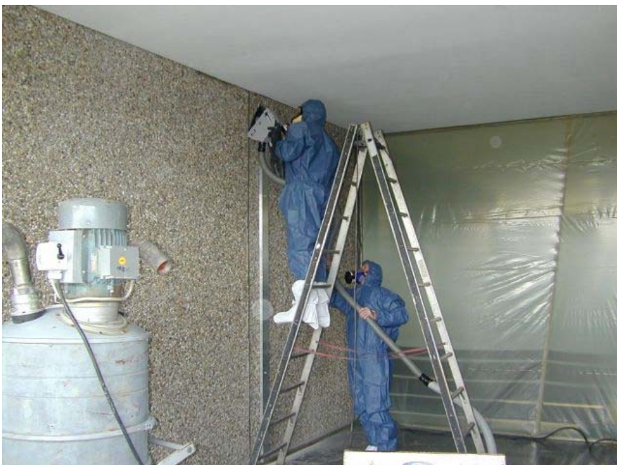
Probeschnitte mit der Mauernutfräse an einer Waschbetonwand im Treppenhaus, Trakt C
