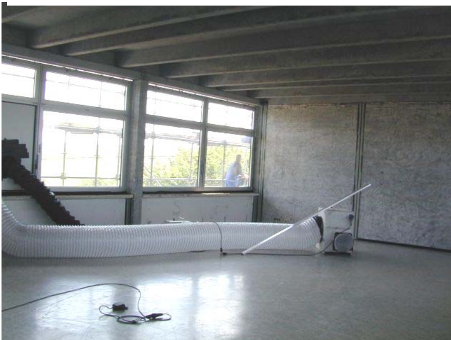
Saniertes und gereinigtes Klassenzimmer, bereit für eine Kontrollmessung (Raumluft)
