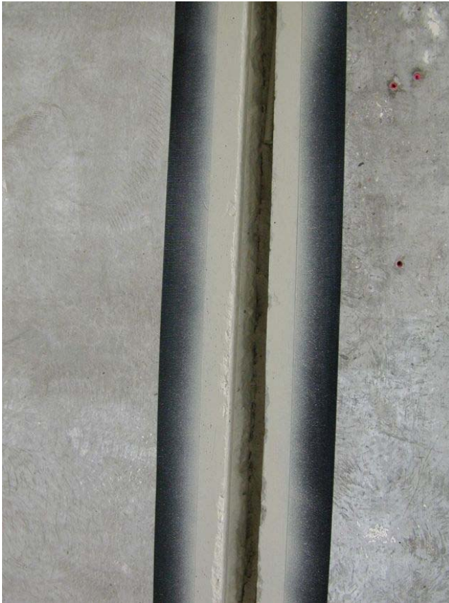
Beschichtete Fugenflanke (Endzustand vor dem Wiederverfüllen) im Innenbereich (Klassenraum)
