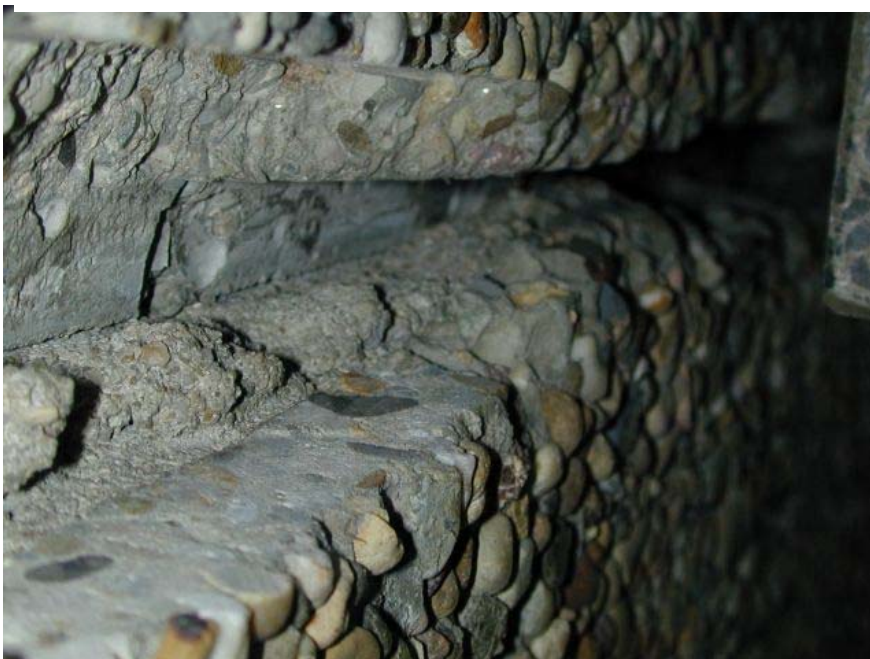
Waschbetonfuge nach Einsatz des Nassschneideverfahrens (Treppenhaus)
