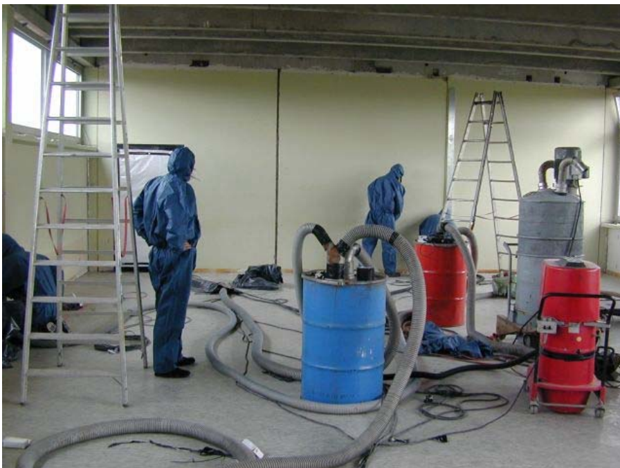
Beginn der Sanierungsarbeiten
