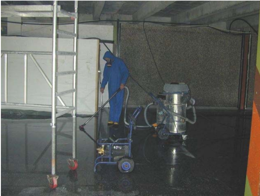
Nassreinigung vor der Abnahme des Sanierungsbereichs (Aula)
