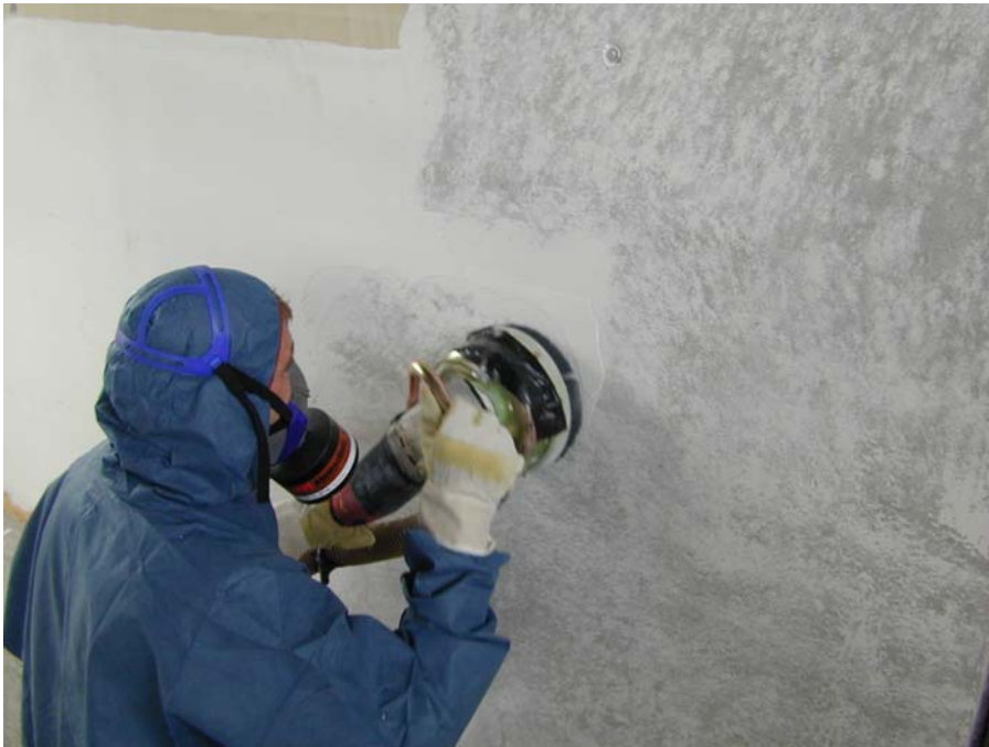
Entfernung der Wandspachtelung mit der Sanierfräse unter Absaugung und Personenschutz
