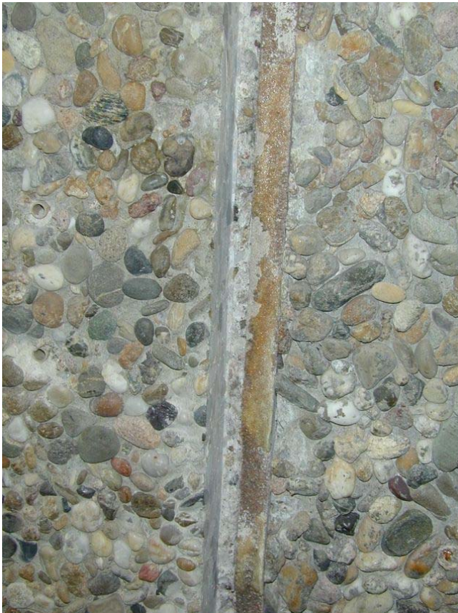
Fugenschnitt der Mauernutfräse im Trockenschnitt
