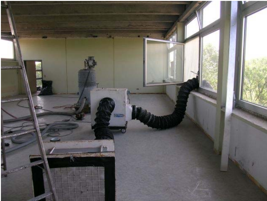
Entkerntes Klassenzimmer in der Vorbereitung zur PCB-Sanierung
