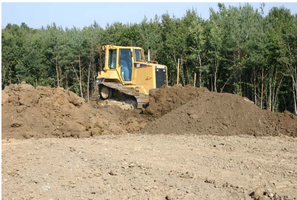
Die 1,70 m starke Rekultivierungsschicht wird aufgebracht
