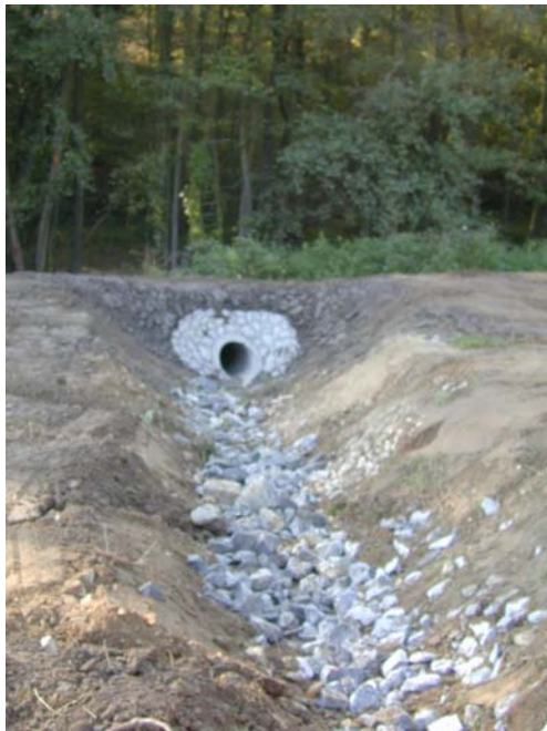
Durchlass (Einlauf und Auslass) beim Neudorfer Graben
